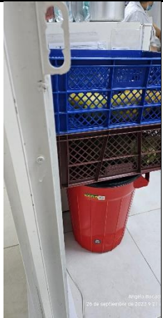
Sistema de aprovechamiento de agua de lavado de frutas y verduras en area de cocina en contenedor rojo
