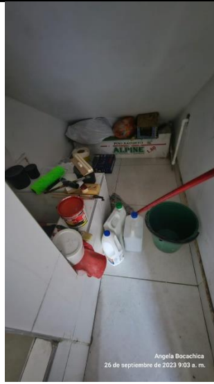
Se solicita reubicación de los elementos almacenados al lado de la poceta
