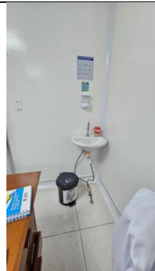
Lavamanos, jabón líquido para manos, área que no cuenta con toallas de papel, del área de cuidado a la salud
