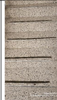
Se solicita ajuste de perfil y baldosa de acceso en escaleras
