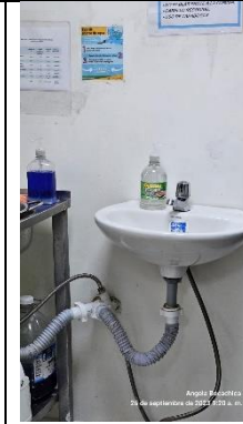
Lavaplatos con insumo de aseo sin hoja de seguridad, del área de cocina
